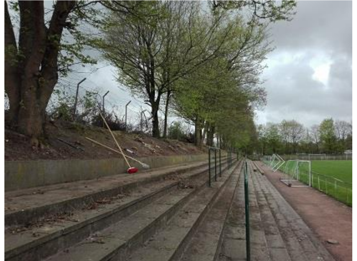
Reinigungsarbeiten an der Tribüne beim SV Duisern
