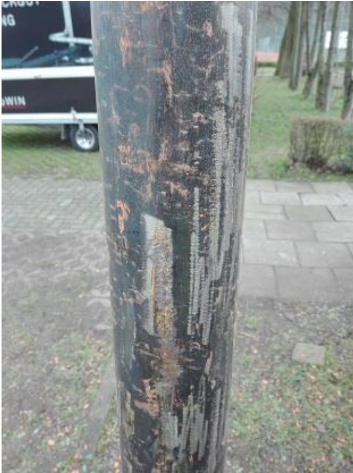
Anschleifen einer Laterne am ETUS Bissingheim auf dem Parkplatz.
