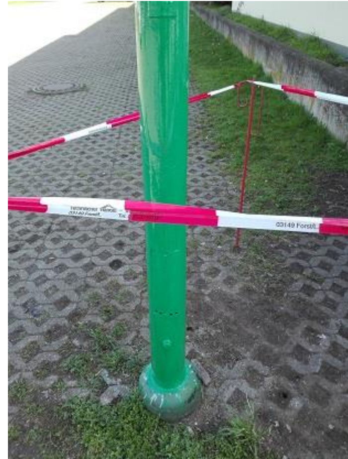
Verschönerungsarbeiten an der Laterne nach dem Abschleifen beim ETUS Bissingheim.
